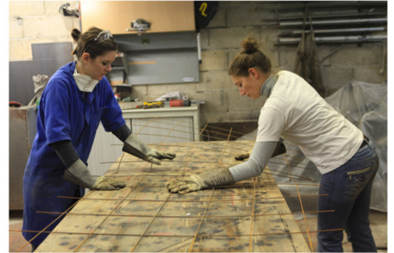
Dépliage des treillis
