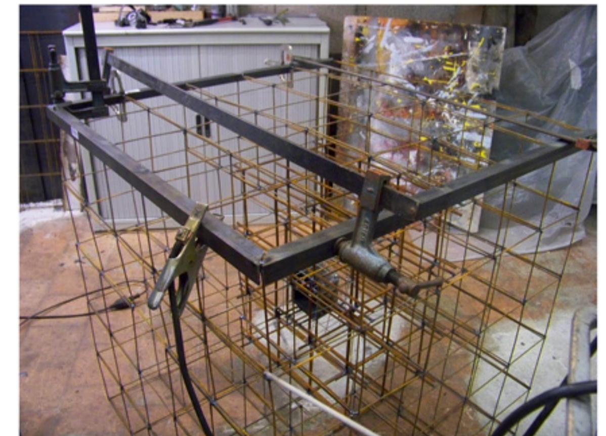
Découpe et soudure des cornières en acier
