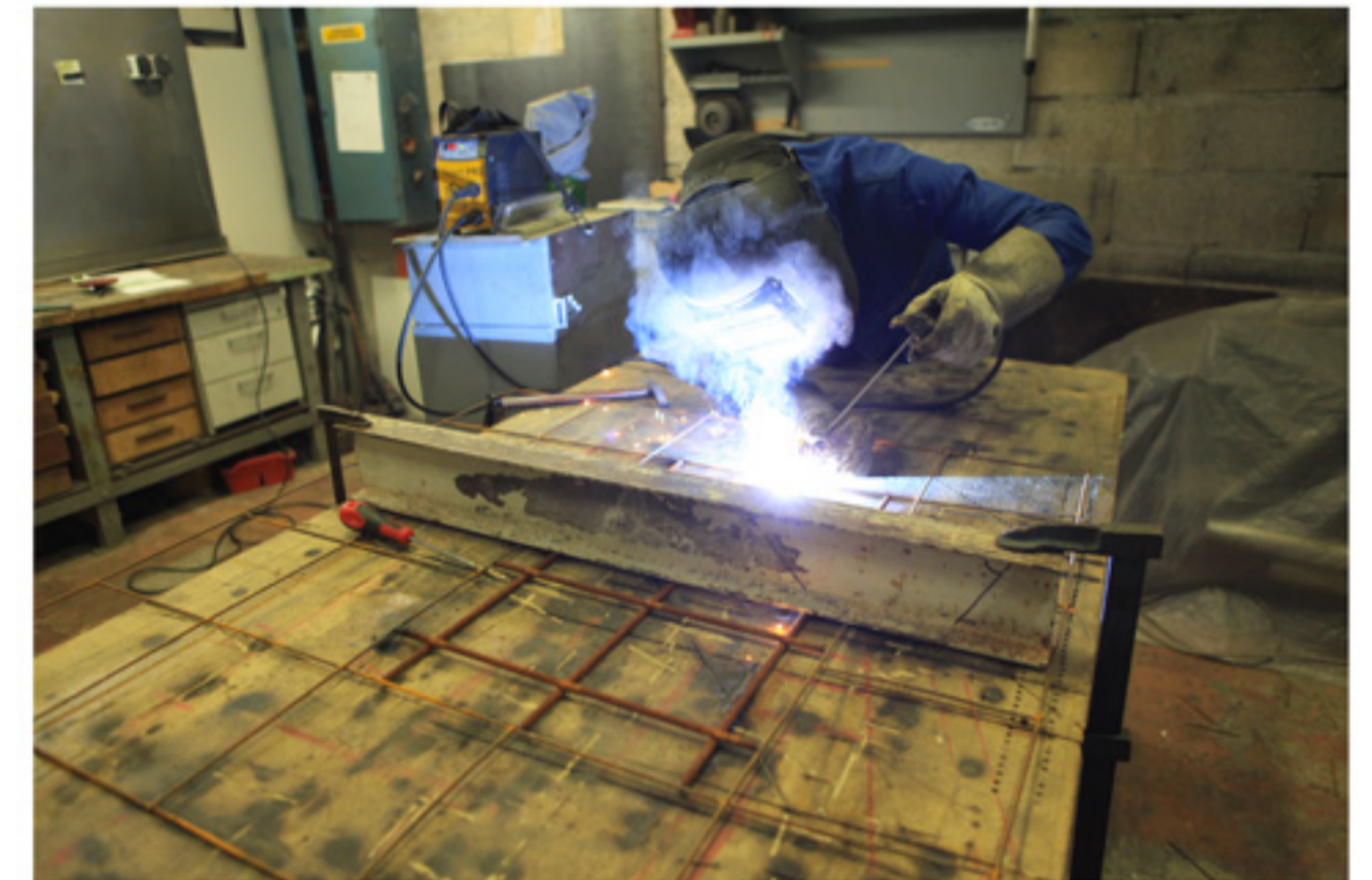
Soudure des treillis de différentes trames entre eux
